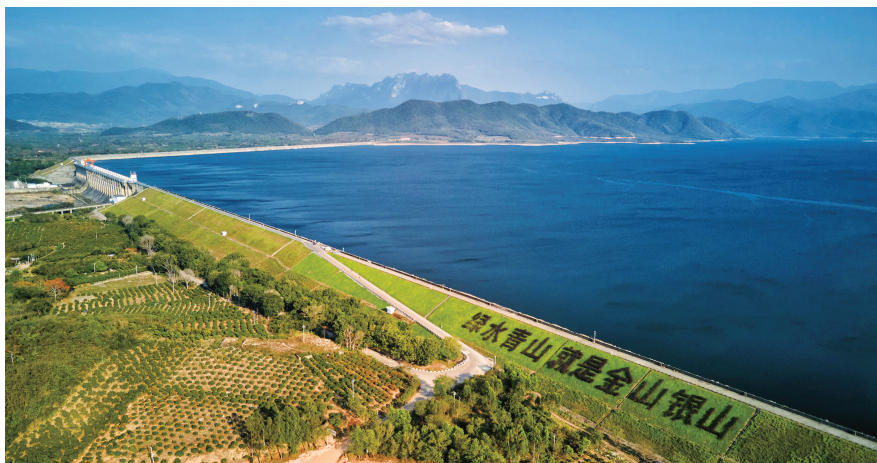
近日,大广坝水利水电二期(灌区)工程已完成验收。该工程涉及灌溉面积101万亩,建成后工程将极大改善东方、昌江和乐东的灌溉用水条件,解决灌区范围内农村人畜饮水不安全问题。封烁/摄
