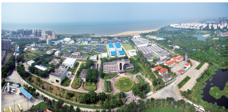
国开行承销债券支持海口水务集团白沙门污水处理厂一期建设。国开行海南省分行供图
