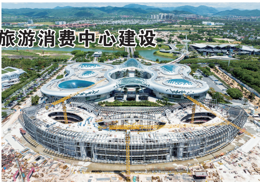
俯瞰正在建设中的三亚国际免税城一期二号地商业项目,预计2023年6月全面竣工。武威/摄
