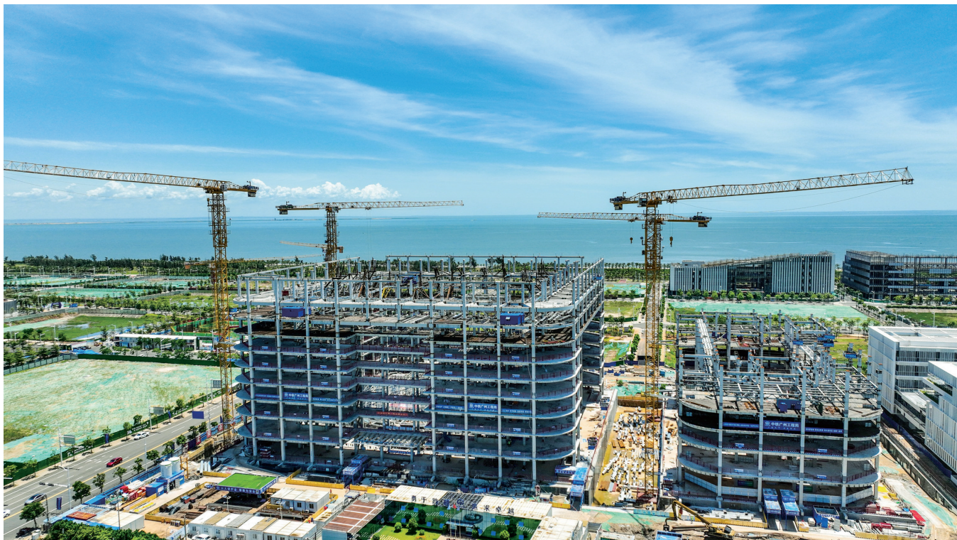
海南银行总部大楼项目地下室主体结构已完成施工,总工程进度已过半,预计2023年4月底竣工。张茂/摄
