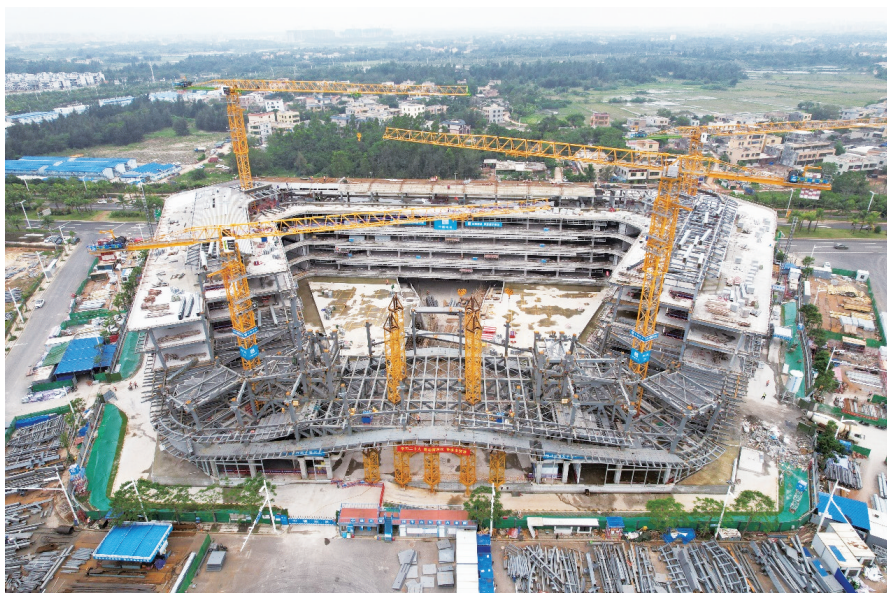
图为海口江东新区江东发展大厦。该项目由中建三局(海南)有限公司承建,总建筑面积89356.01平方米,地上部分采用装配式钢结构体系。
