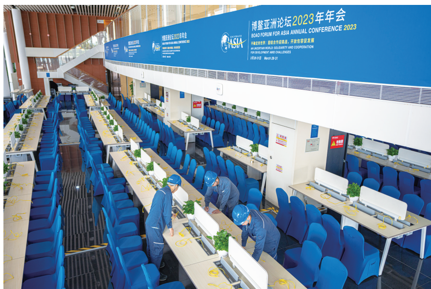
琼海供电局工作人员在博鳌亚洲论坛新闻中心开展保供电检查工作。袁琛/摄
