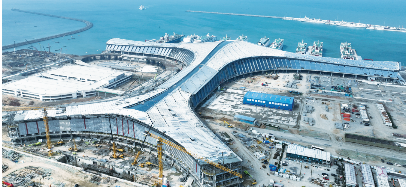
俯瞰海口新海滚装码头客运综合枢纽站工程项目。项目建成后,将实现游客过海“零换乘”,大大提高海口新海港的服务水平。武威/摄
