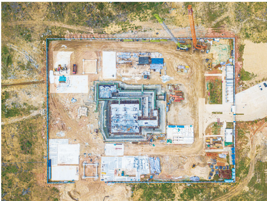
航拍我国首个开工建设的商业航天发射场——海南商业航天发射场。蒲晓旭/摄
