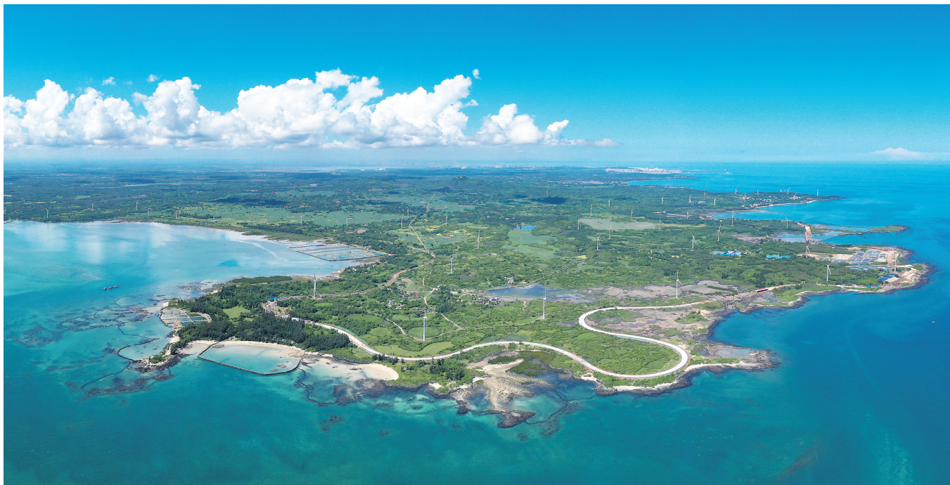
海南环岛旅游公路儋州段施工现场。郭程/摄
