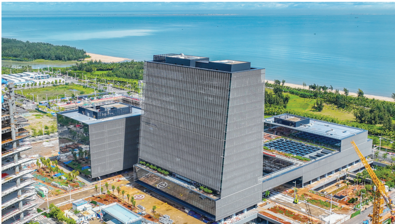
中银海南总部项目完成幕墙安装。张茂/摄
