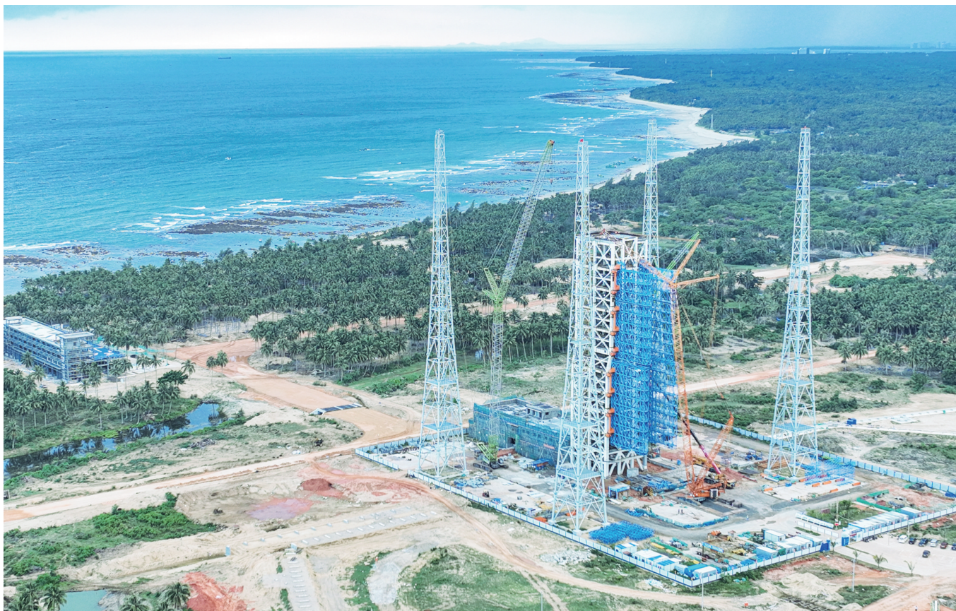
▲ 为确保实现 2024 年常态化发射，发射场的设备生产和现场施工同步进行。图为文昌市海南商业航天发射场项目工地。袁琛/摄
