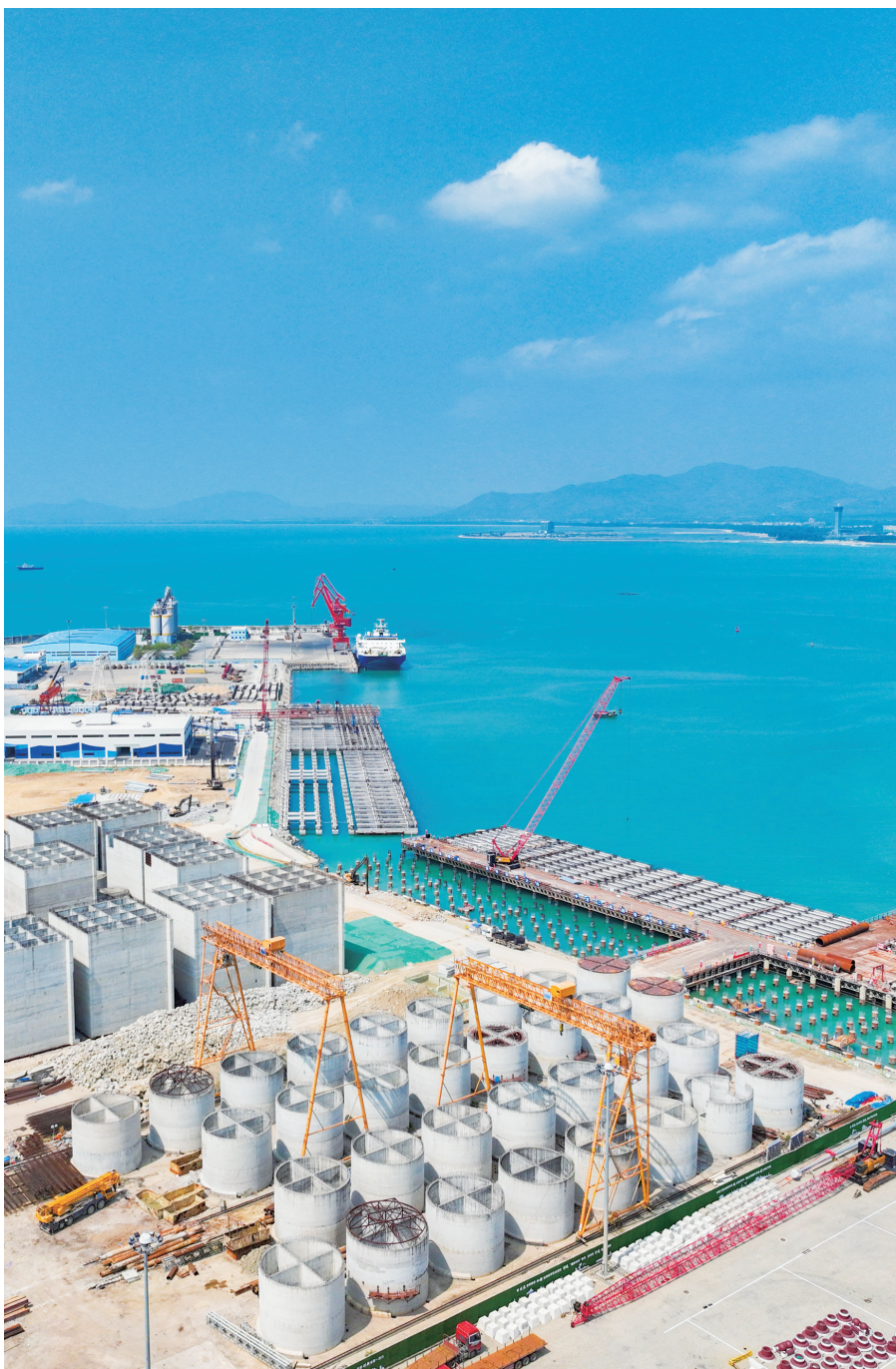
俯瞰三亚港南山港区对外开放口岸、“二线口岸”现场查验能力建设项目施工现场。王程龙 / 摄
