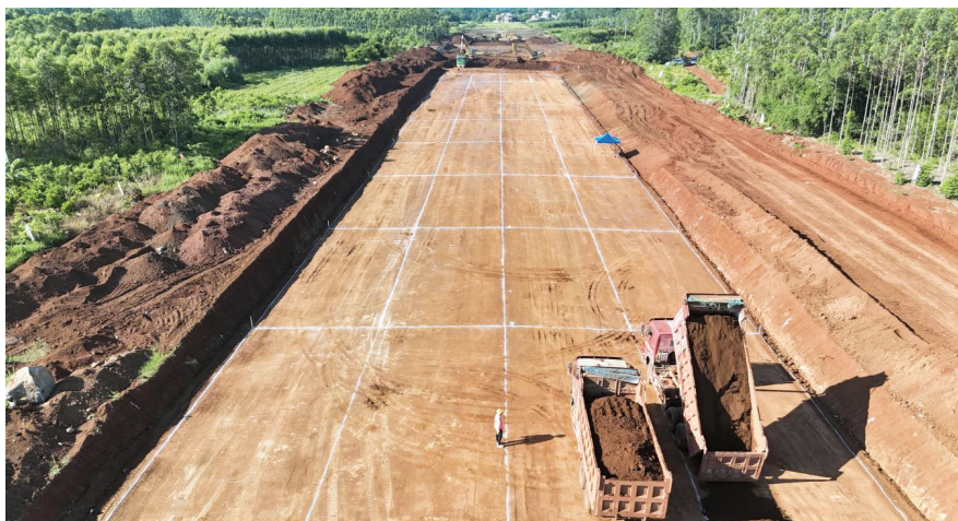
临高金牌港开发区港口及配套工程项目疏港快速路
