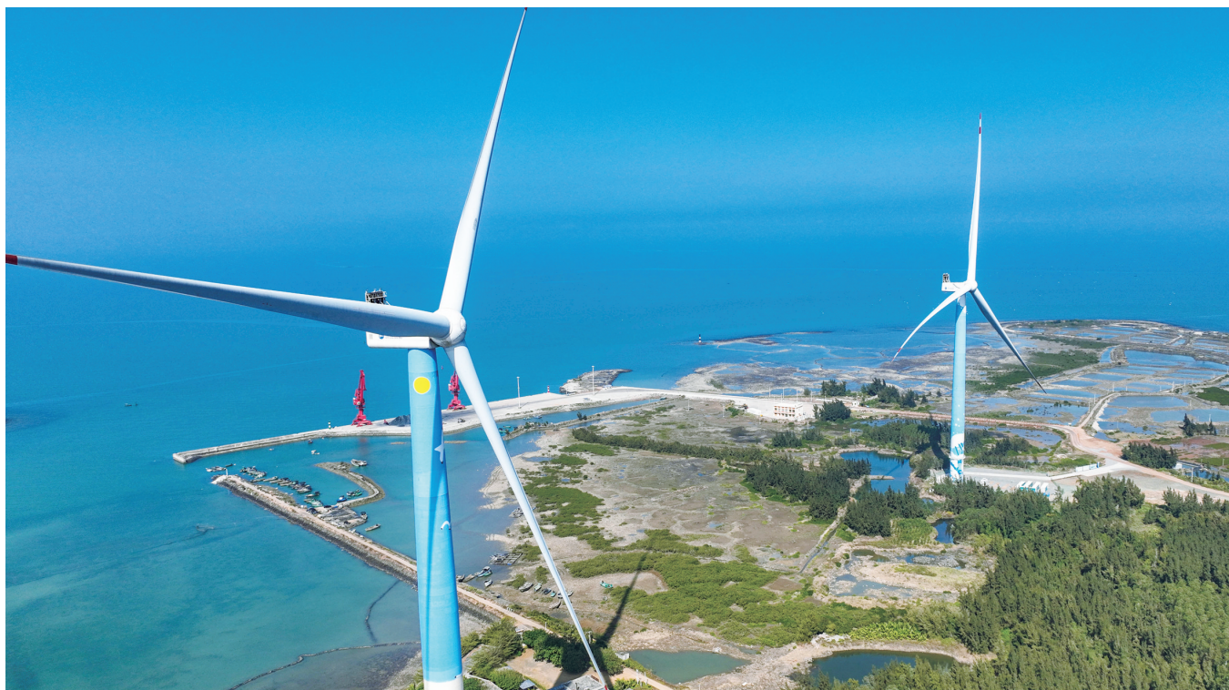
海南(临高)大型海上风电机组检测试验创新中心,机组有序运行。陈元才/摄
